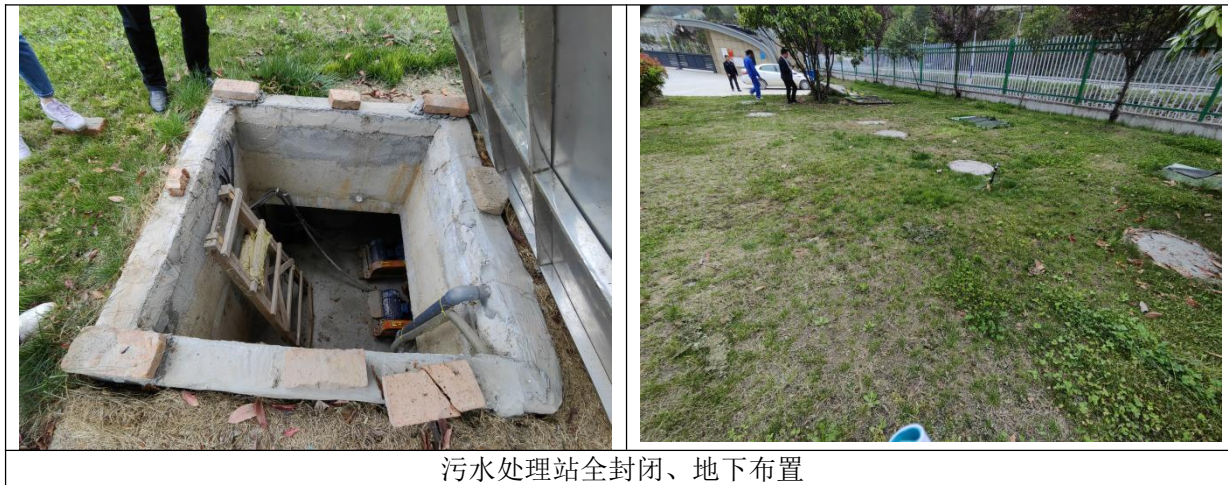
图 4.1-2 污水处理站现场情况
